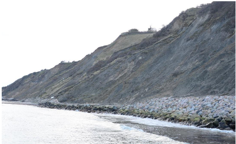
Figur 3.6 Stejl og høj skråning og lav skråningsbeskyttelse ved Salgårdshøj. Der er ingen strand foran skråningsbeskyttelsen.
