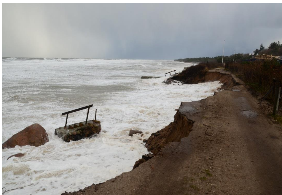
Figur 3.8 Akut erosion af skrånningen ved Havstokken, Udsholt, Gribskov Kommune, under stormen Bodil 06.12.2013
